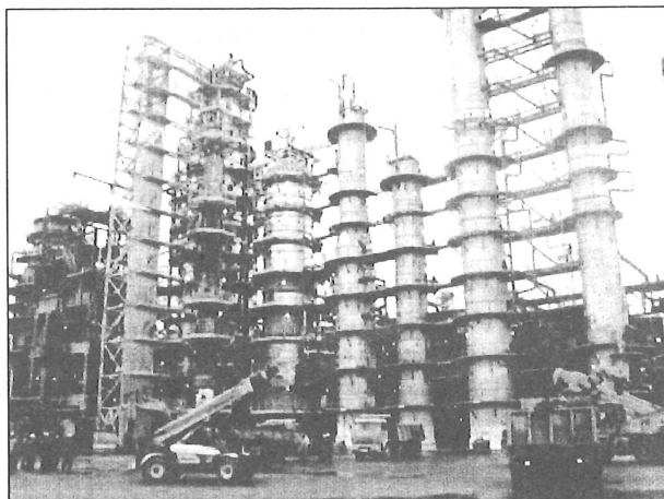
Рис. 4. ООО «КИНЕФ», реконструкция установки ЭЛОУ-АВТ-6 с заменой ректификационных колонн
